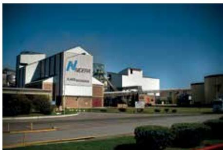
En 2015 Nidera comenzó a utilizar como combustible en la planta de Saforcada, Provincia de Buenos Aires, la biomasa generada como subproducto del proceso de elaboración de aceite de girasol. El proceso consiste en la reutilización del residuo de la cáscara de girasol, convirtiéndolo en una fuente de energía
