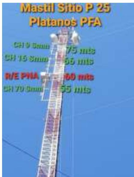
Figura 9 -Ubicación en torre existente de tres antenas de canales VHF y el nuevo radioenlace orientado hacia LPLA - Prefectura La Plata
