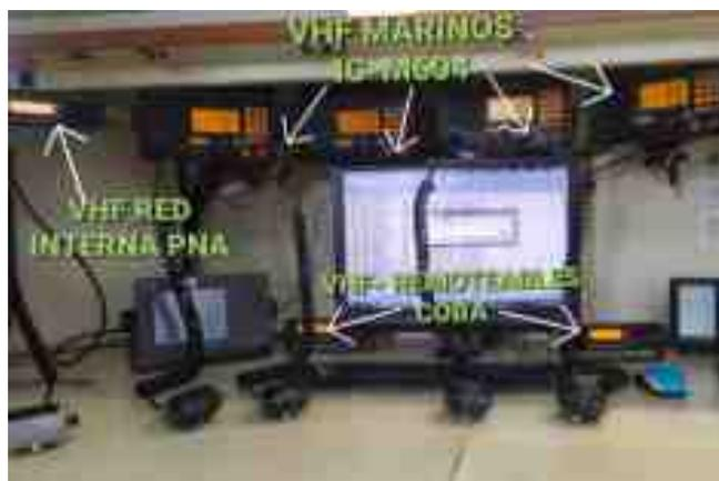
Figura 1 – Distribución de equipos VHF en el puesto operador
